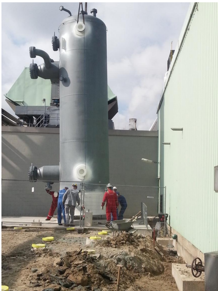
Plaatsing van de stoom-stoom warmtewisselaar
